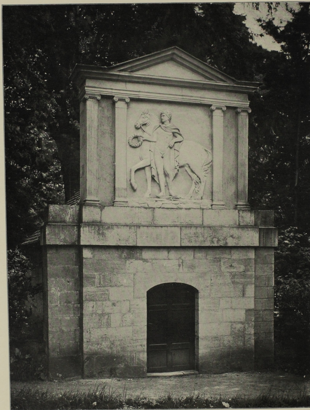
Gerätehaus im Park zu Wörlitz. Erdmannsdorff
