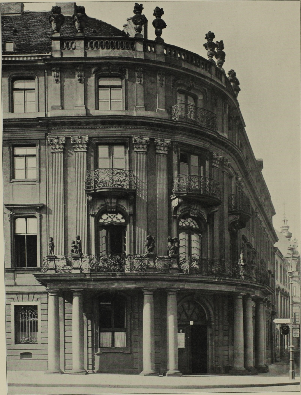
Ephraimshaus Poststraße 16. Von Dietrichs 1762–1765
