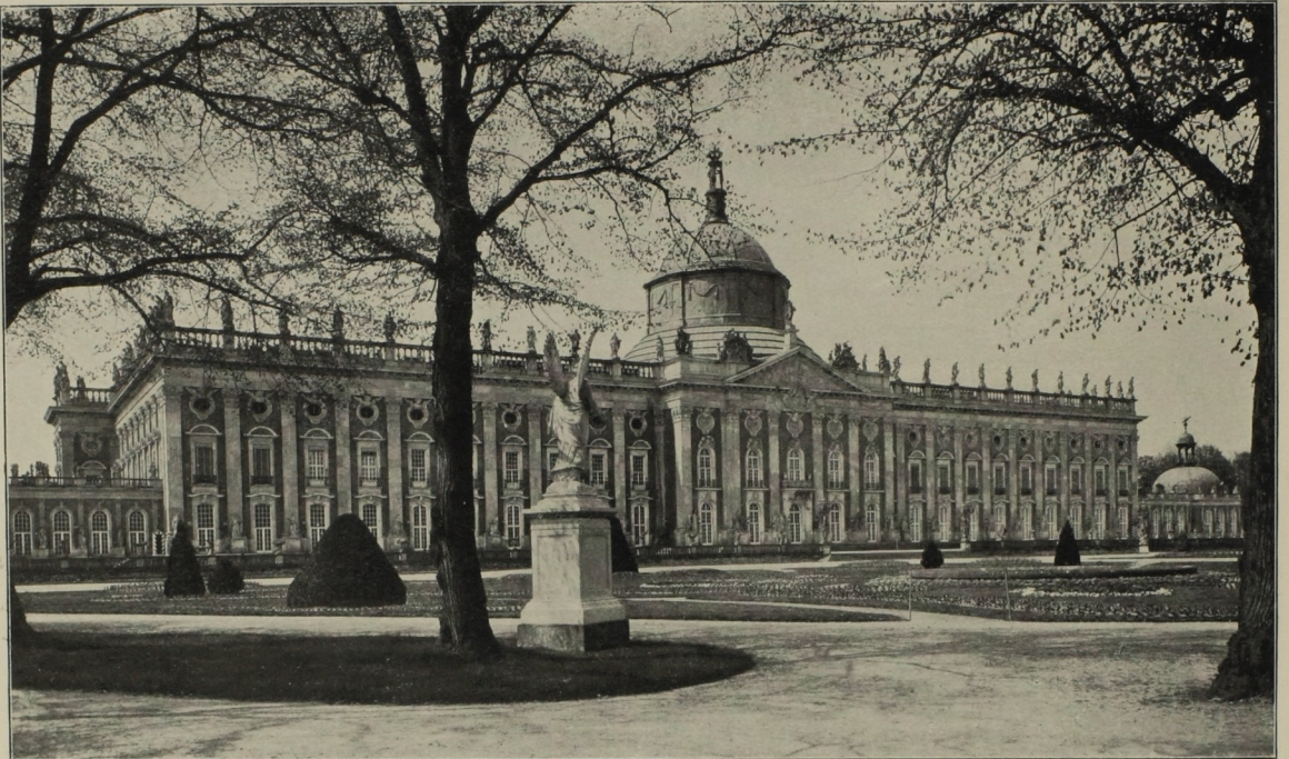
Neues Palais bei Potsdam. Von Büring und Manger 1763–1770
