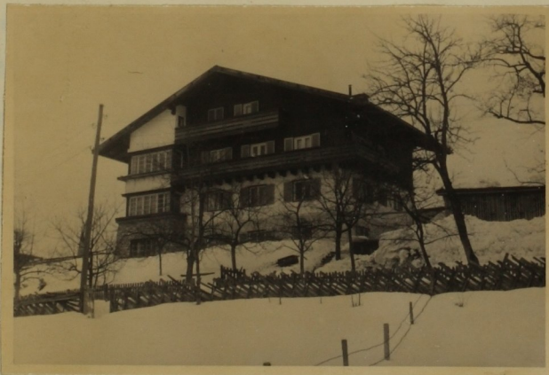
20, Ein Wohnhaus in ortsüblicher Baueife,
