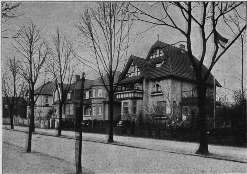
Abb. 1278. Einzelhausgruppe, An der Marienanlage.
