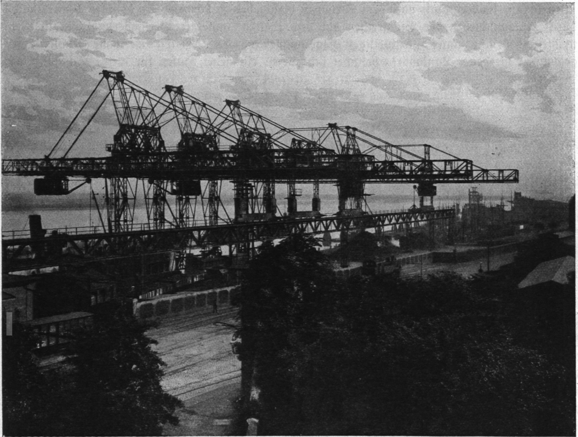
Abb. 1209. Kohlenverladeanlage der Altonaer Kai- und Lagerhaus-Gesellschaft.
