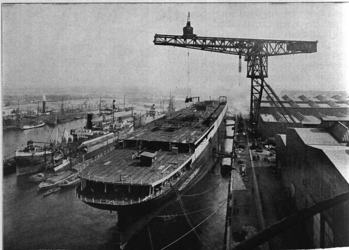
Abb. 990. Vulcan-Werke, 200-t-Werftkran mit „Imperator“.
