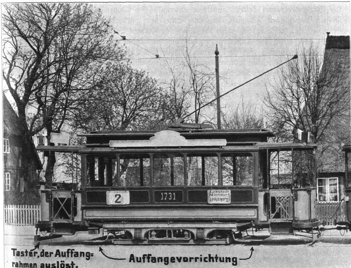
Abb. 873. Schutzvorrichtungen der Straßenbahnwagen.
