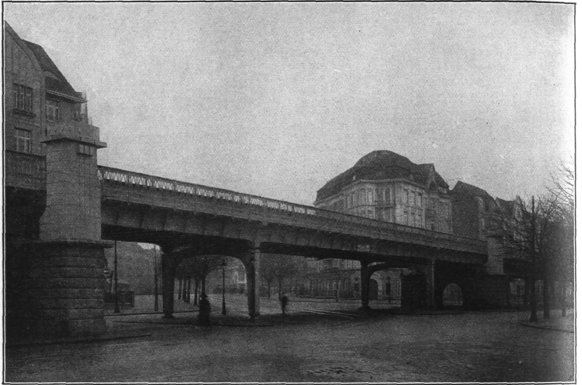
Abb. 830. Viadukt in der Isestraße.
