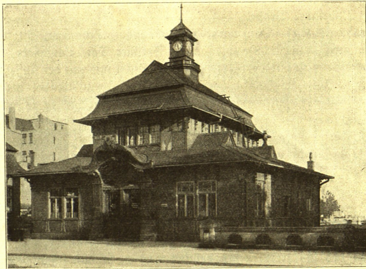
Abb. 795. Haltestelle Wandsbeker Chaussee, Bahnhofsgebäude.
