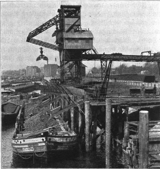
Abb. 776. Gaswerk Tiefstack, Ansicht von der Wasserseite, Ausschläger Elbdeich.
