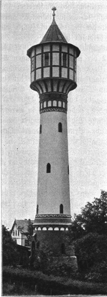
Abb. 740. Wasserturm in Noorburg.
