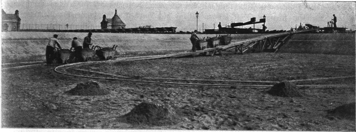
Abb. 692. Filterreinigung.
