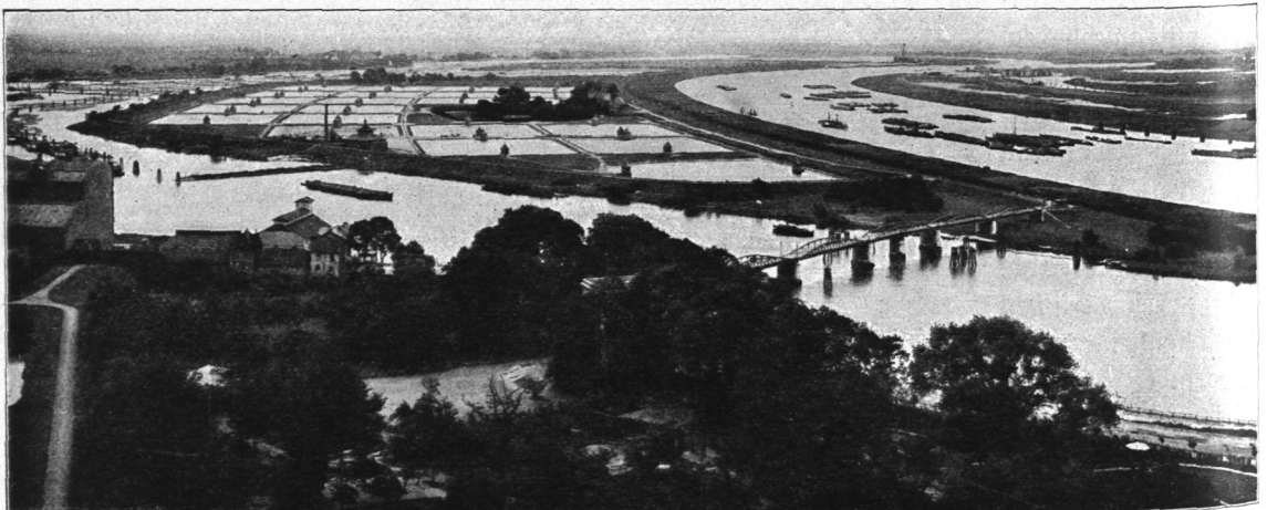
Abb. 686. Filterwerk Kaltehofe, vom Wasserturm in Rothenburgsort gesehen.
