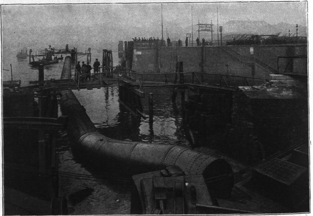
Abb. 648. Dükerverfenkung durch den Niederhafen, Endrohr in der Schwimmmlage.
