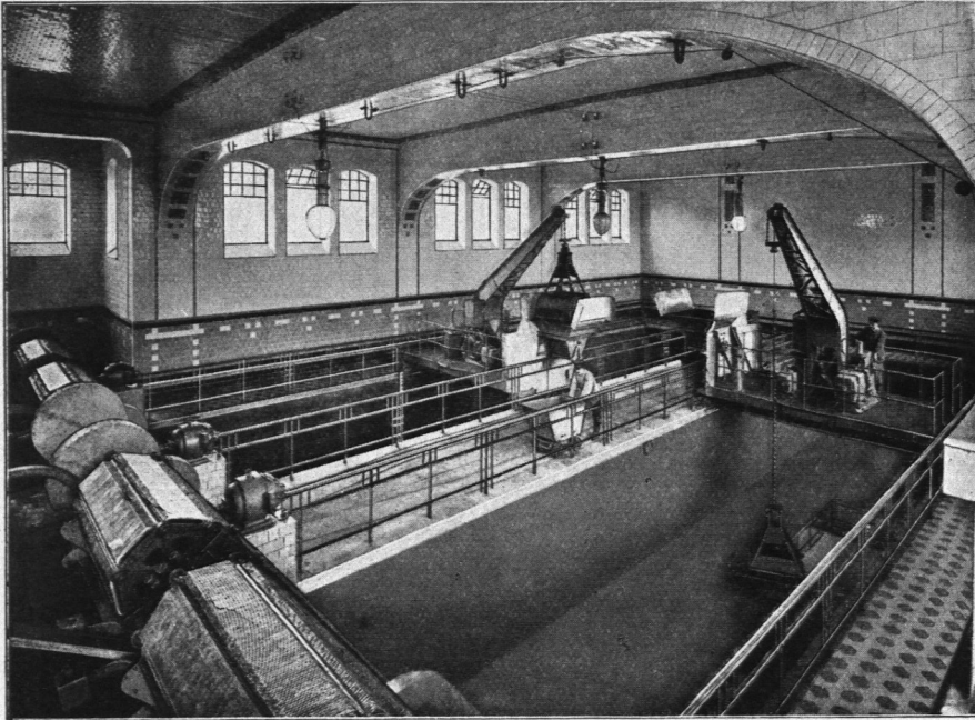
Abb. 639. Abfischanlage des südlichen Elbufers, Ansicht der Sandfänge mit Greifbagger.
