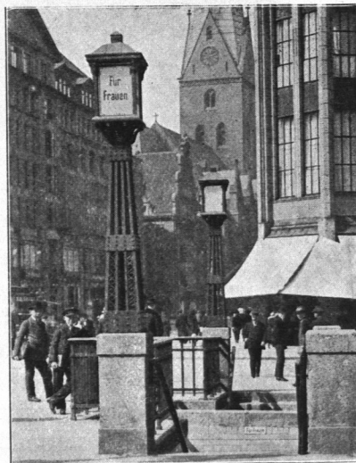
Abb. 580. Beleuchtungskörper an dem Zugange der unterirdischen Bedürfnisanstalt in der Mönckebergstraße.
