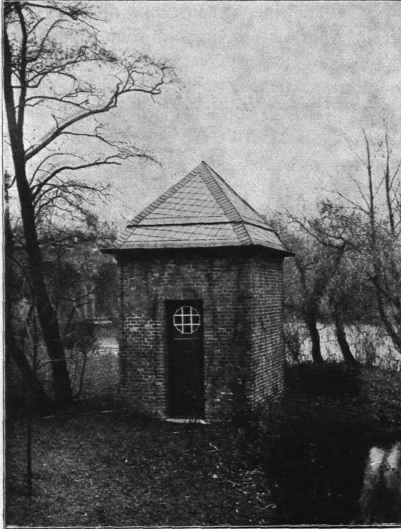
Abb. 558. Pegelhäuschen an der Krugkoppelbrücke.
