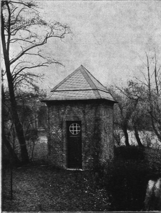
Abb. 558. Pegelhäuschen an der Krugkoppelbrücke.
