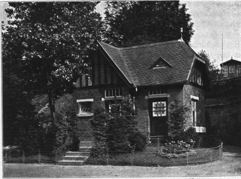
Abb. 537. Bedürfnisanstalt Horner Landstraße, Ansicht.
