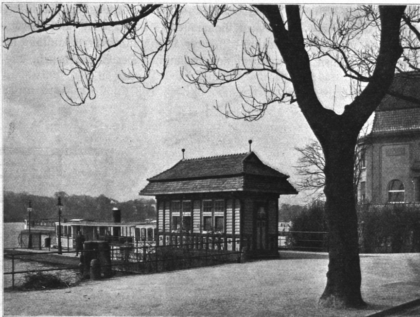
Abb. 525. Wartehalle an der Alsterfähre, Uhlenhorster Seite, Ansicht.
