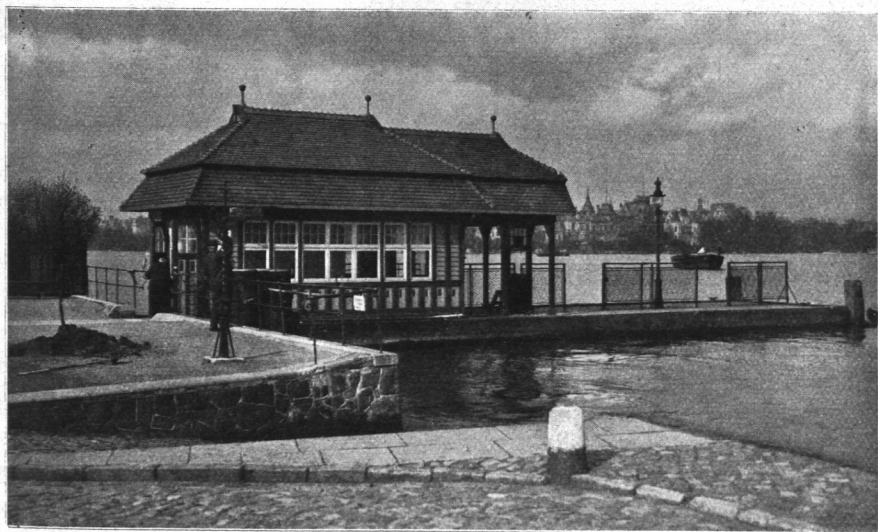
Abb. 528. Wartehalle an der Alsterfähre, Harvestehuder Seite, Ansicht.
