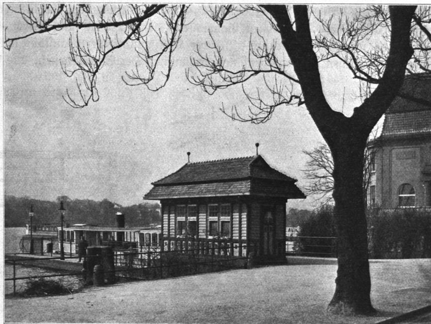
Abb. 525. Wartehalle an der Alsterfähre, Uhlenhorster Seite, Ansicht.
