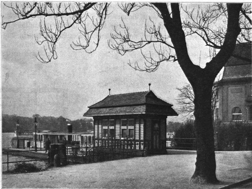
Abb. 525. Wartehalle an der Alsterfähre, Uhlenhorster Seite, Ansicht.
