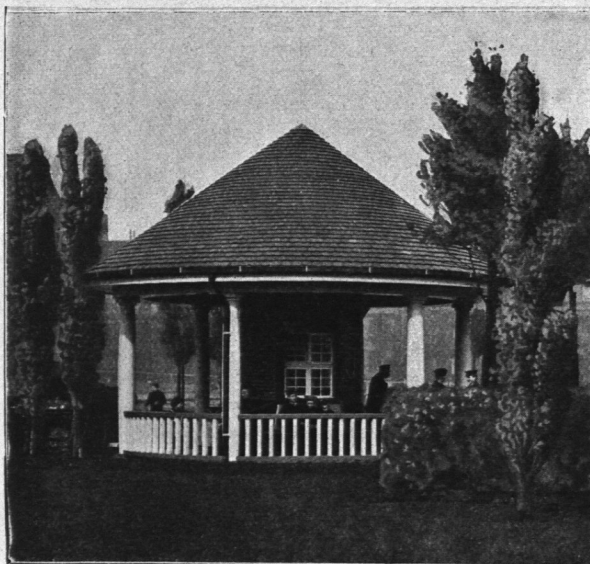
Abb. 453. Grünanlage Landwehr, Schughütte, Ansicht.
