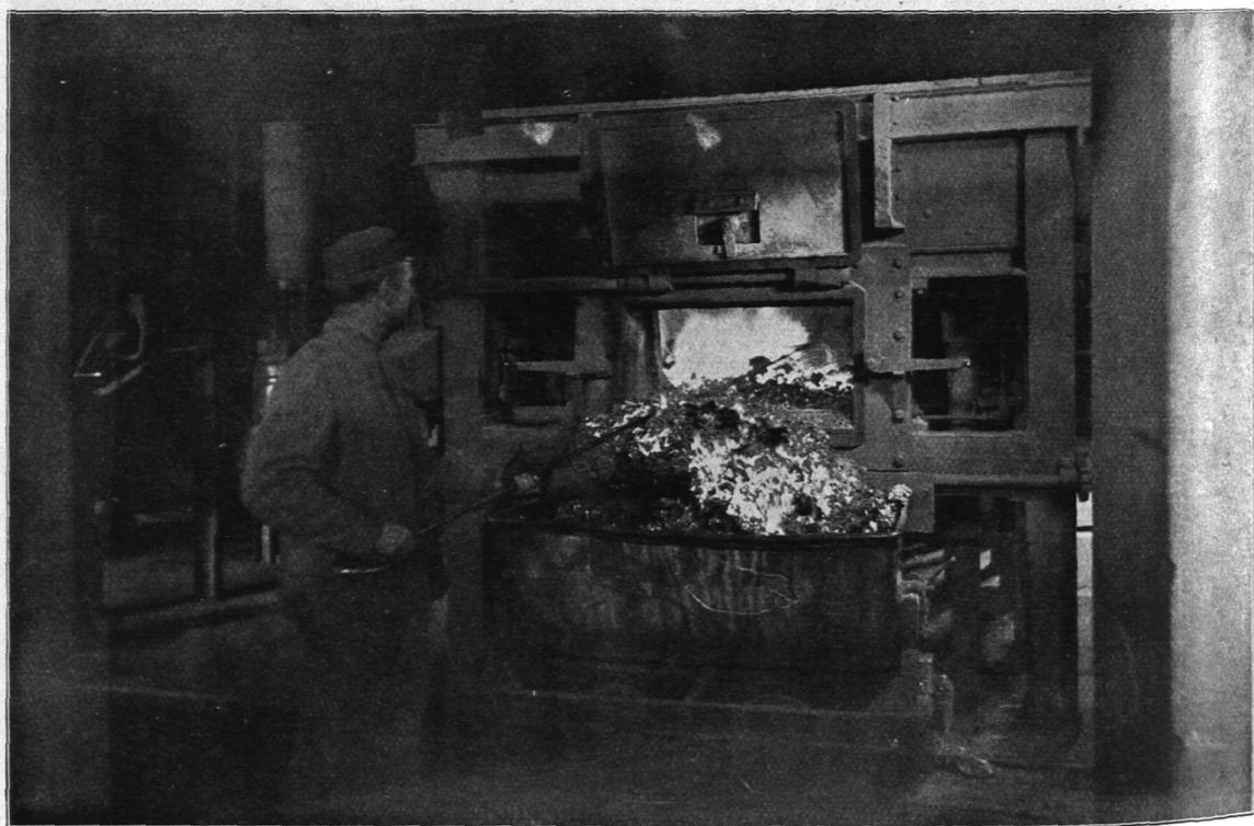
Abb. 419. Verbrennungsanstalt am Alten Teichweg, Entschlackung eines Ofens.
