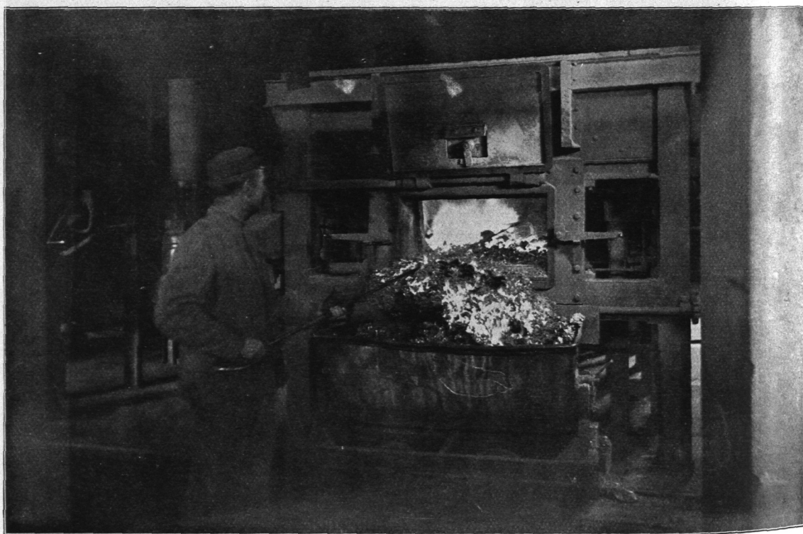
Abb. 419. Verbrennungsanstalt am Alten Teichweg, Entschlackung eines Ofens.
