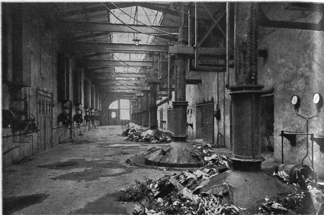
Abb. 418. Verbrennungsanstalt am Alten Teichweg, Ofenhalle.
