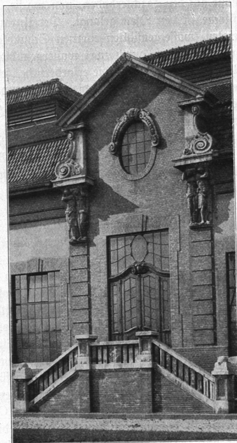
Abb. 414. Verbrennungsanstalt am Alten Teichweg, Einzelheiten des Haupteinganges.
