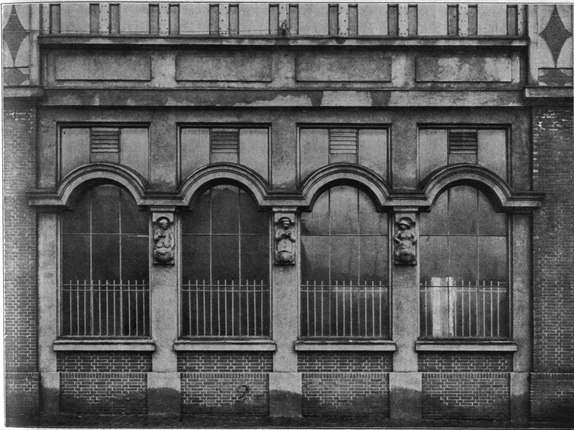
Abb. 378. Nördliche Markthalle, Einzelheiten der Fenstergruppe.
