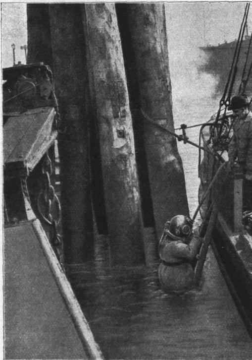
Abb. 176. Ausziehen eines am Grunde gebrochenen Pfahles.
