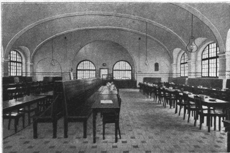
Abb. 152. Speisehalle am Bremer Kai, Innenansicht des Speisesaales.
