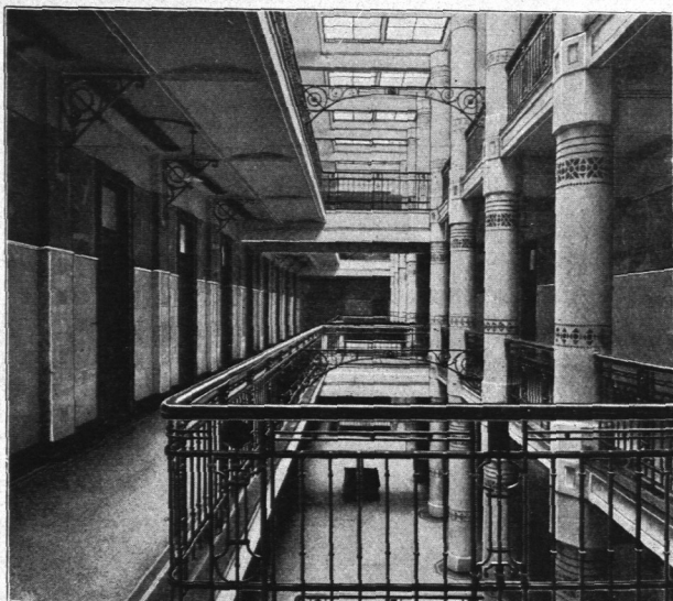
Abb. 146. Umbau des Speicherblocks O, Kontorhaus, Blick in das Innere, Sandtorkai Nr. 14 bis 17.
