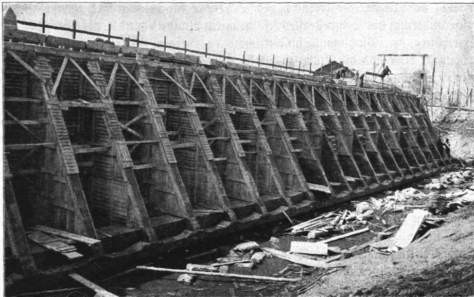
Abb. 85. Rückansicht der Ufermauer aus Eisenbeton. (Kojkanal.)
