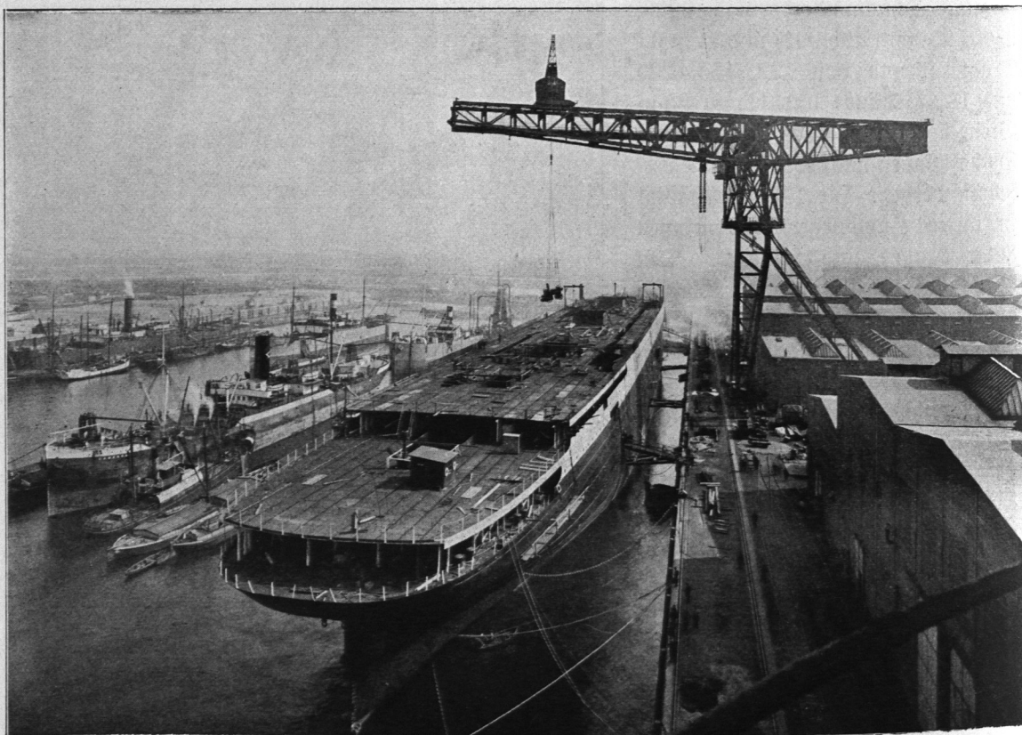
Abb. 990. Vulcan-Werke, 200-t-Werftkran mit „Imperator“.
