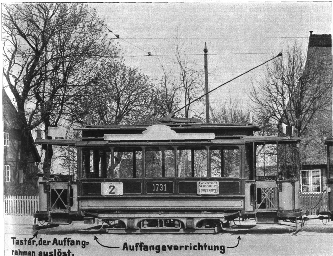
Abb. 873. Schutzvorrichtungen der Straßenbahnwagen.
