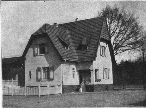
Abb. 812. Haltestelle Dhlisdorf, Wohngebäude.
