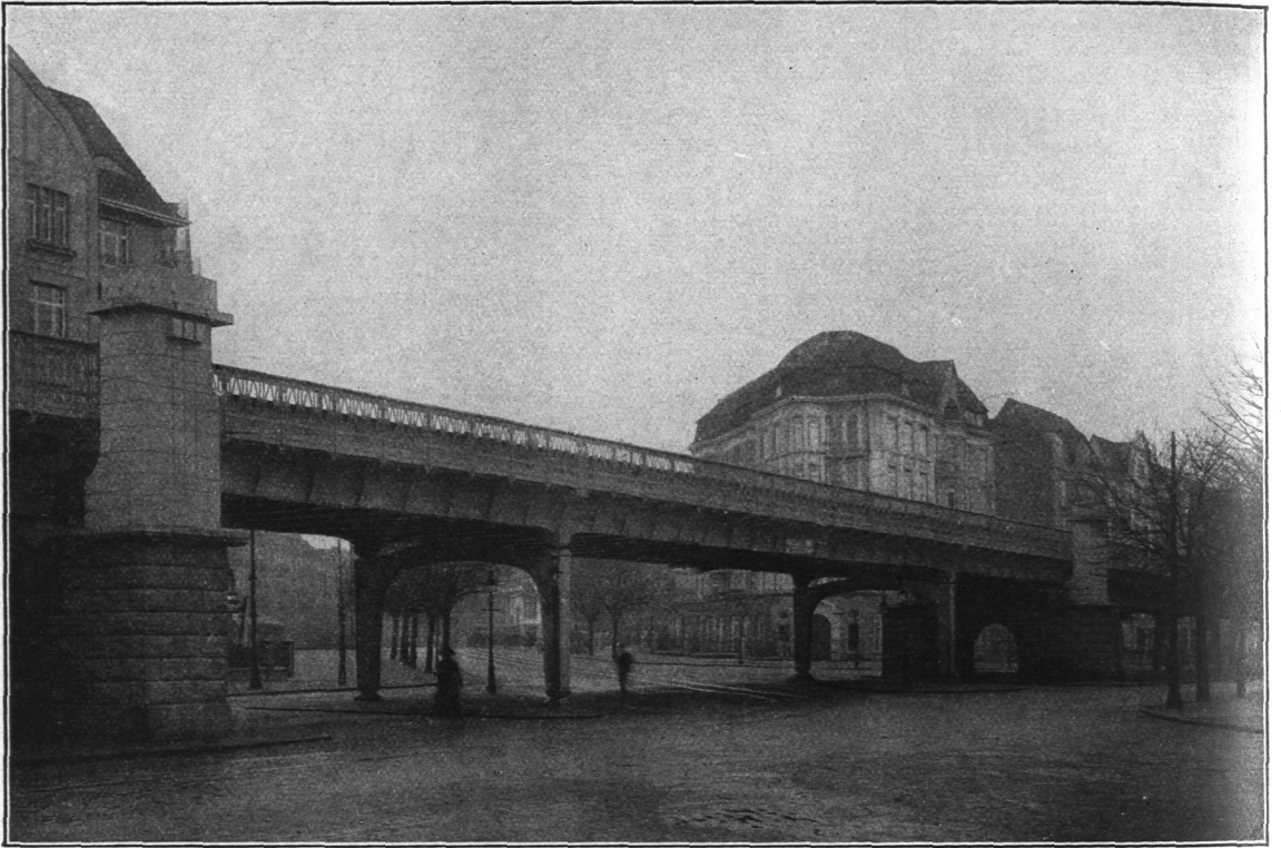
Abb. 830. Viadukt in der Isestraße.
