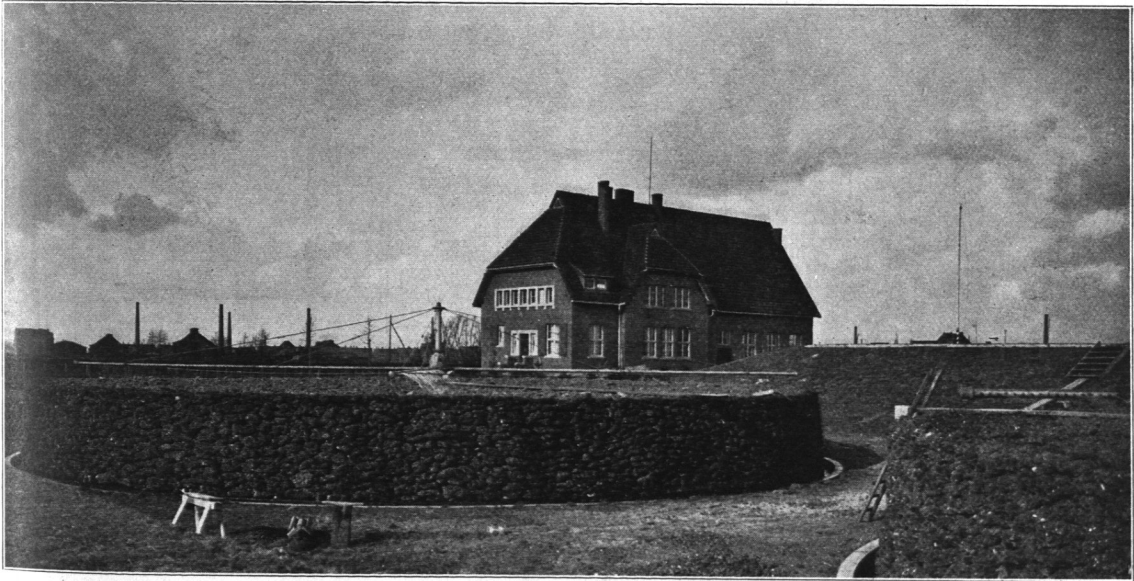
Abb. 665. Biologische Kläranlage Bergedorf, Sprinkler und Dienstgebäude.
