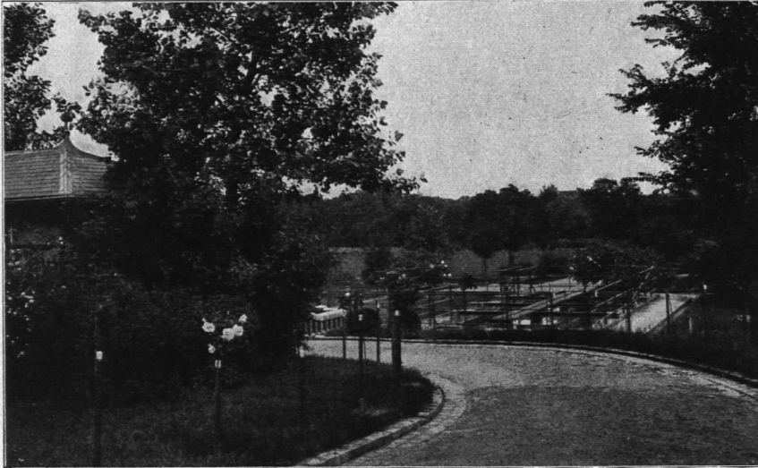
Abb. 662. Biologische Kläranlage für das zweite Gefängnis in Fuhlsbüttel, vom Eingang gesehen.
