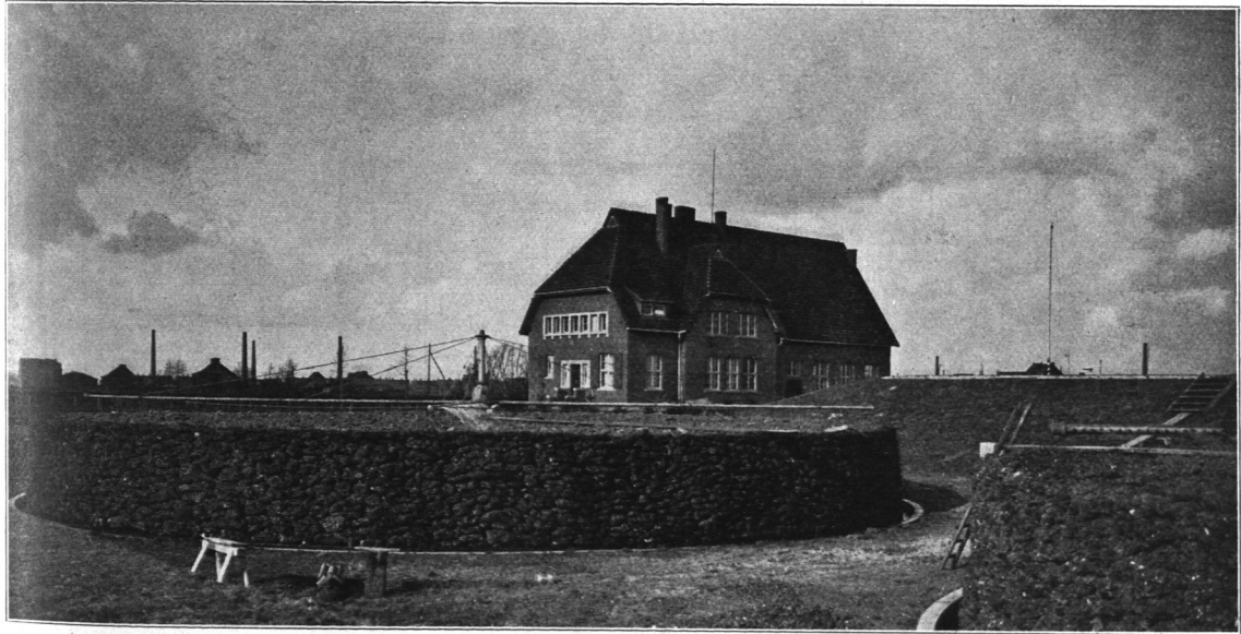
Abb. 665. Biologische Kläranlage Bergedorf, Sprinkler und Dienstgebäude.
