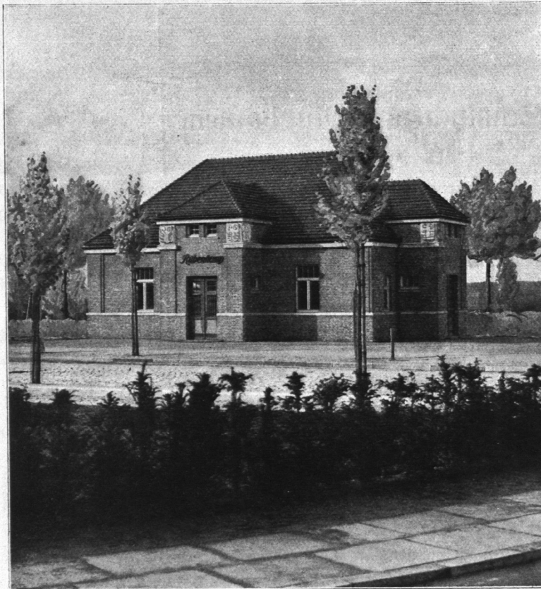
Abb. 509. Wartehalle Rübenkamp, Ansicht.
