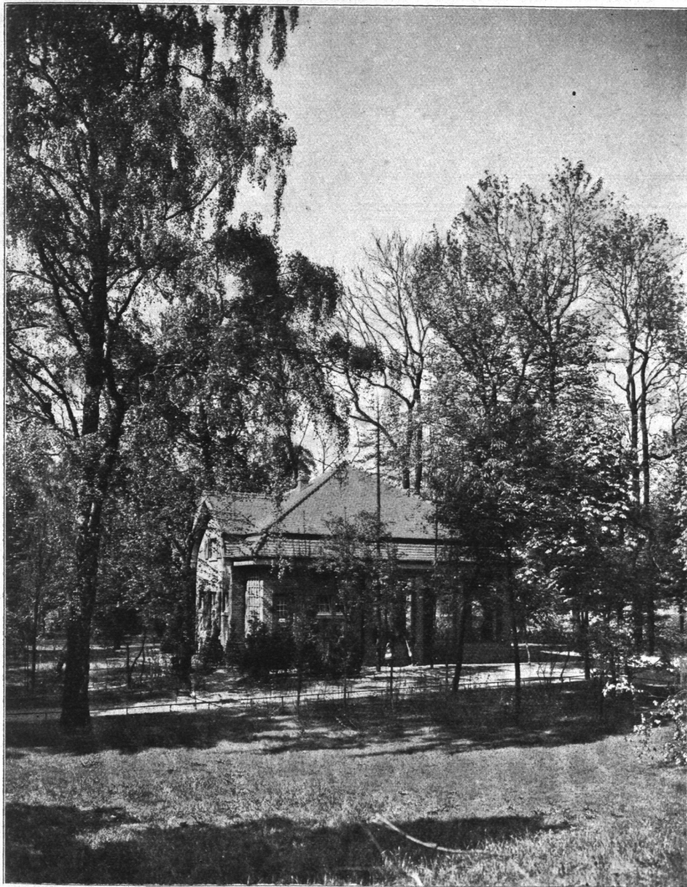
Abb. 545. Bedürfnisanstalt mit Regenschutzbach in den Grünanlagen im Eilbecktal.
