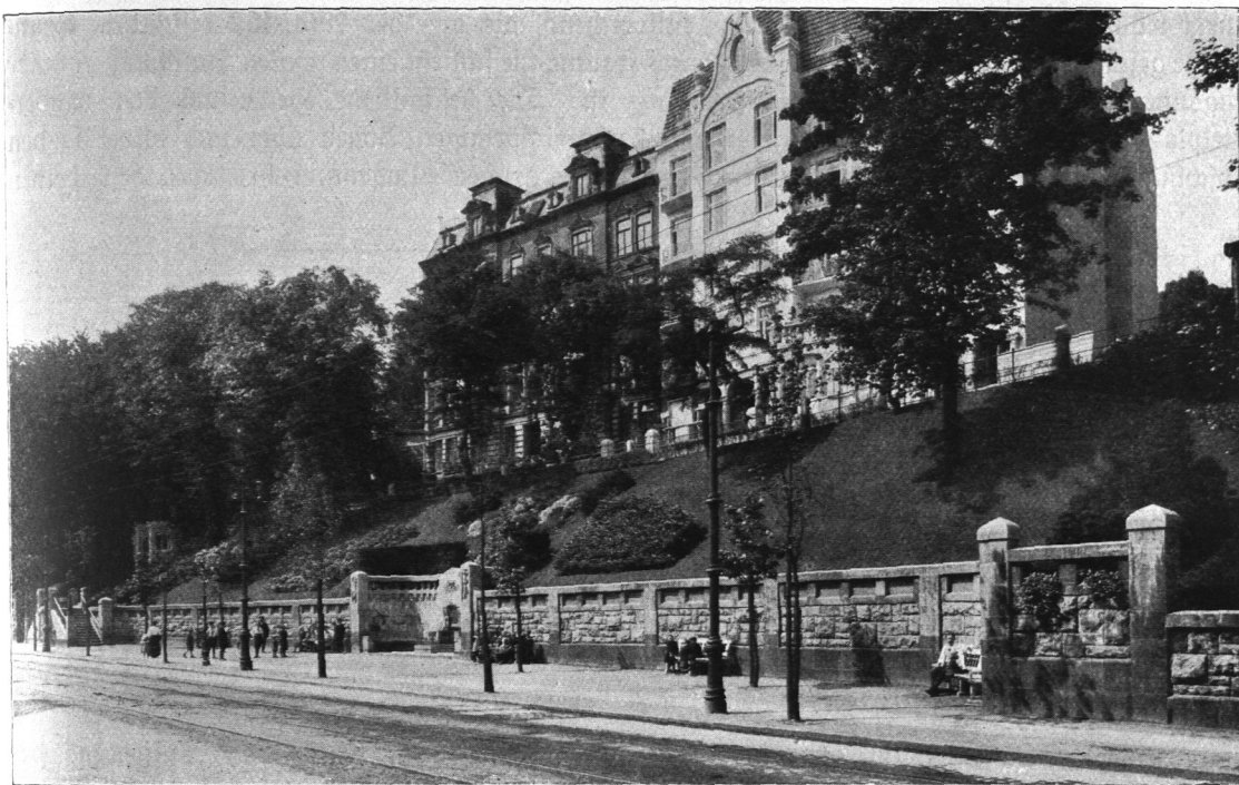
Abb. 450. Anlage Borgfelder Straße, Ansicht.
