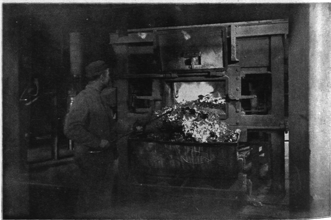
Abb. 419. Verbrennungsanstalt am Alten Teichweg, Entschlackung eines Ofens.
