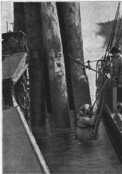
Abb. 176. Ausziehen eines am Grunde gebrochenen Pfahles.
