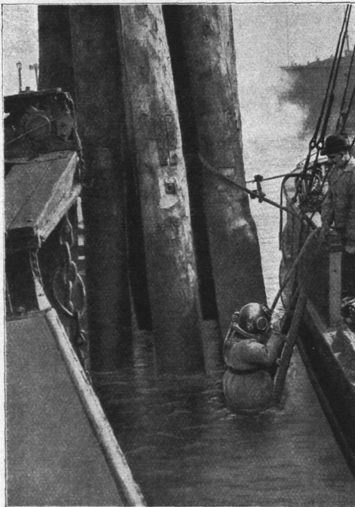
Abb. 176. Ausziehen eines am Grunde gebrochenen Pfahles.
