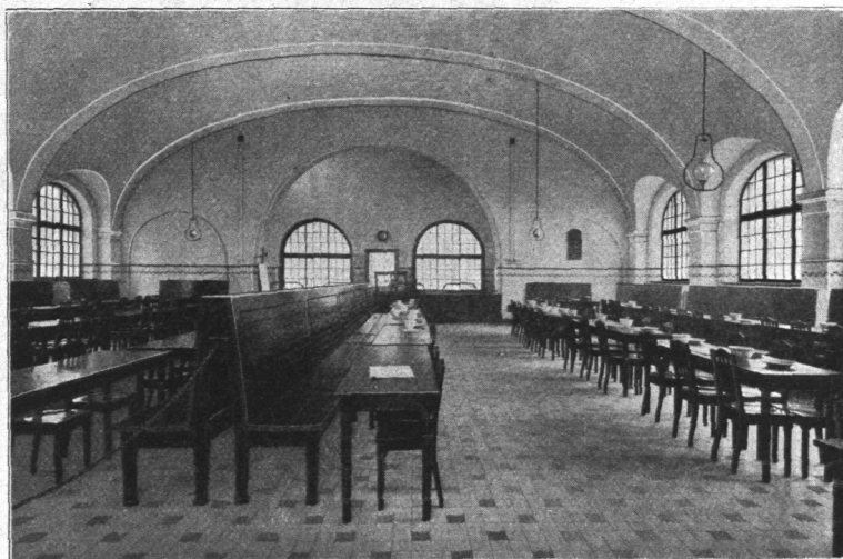
Abb. 152. Speisehalle am Bremer Kai, Innenansicht des Speisesaales.
