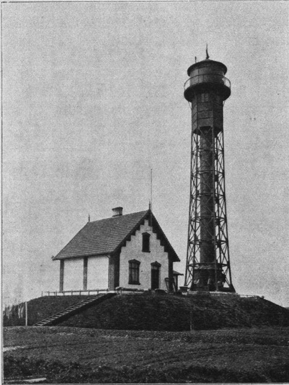
Abb. 60. Oberfeueranlage Bütsfether sand.
