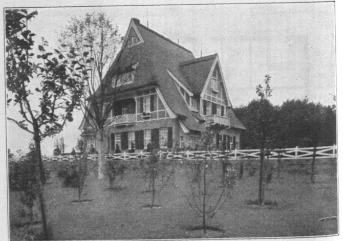
Abb. 1133 und 1134. Landhaus Edm. Heinr. Riege, Wohltorf, erbaut 1912 durch Architekt Heinrich Stövhage. Baukosten 120 000 Mark, für das Kubikmeter umbauten Raumes 35 Mark.
