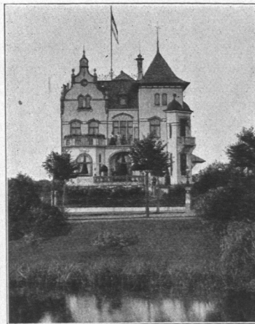
Abb. 1006 und 1007. Haus Zfermann, Bellevue, erbaut 1897 durch Architekt Hugo Groothoff, B. D. U. Baukosten 147000 Mark, für das Kubikmeter umbauten Raumes 33 Mark.
