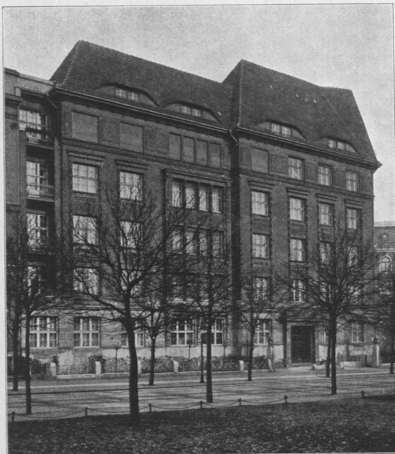
Abb. 978. Haus Moorweidenstraße Nr. 34. Architekt Emil Neupert.
