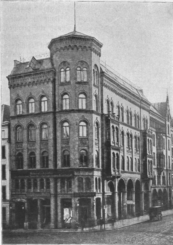
Abb. 959. Haus Brandstvierte Nr. 1 bis 5.
