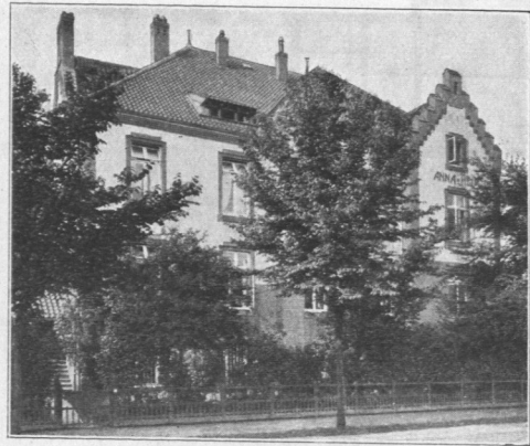
Abb. 574. Annaheim, Ansicht. Architekt Alfr. Löwengard, B. D. A.
