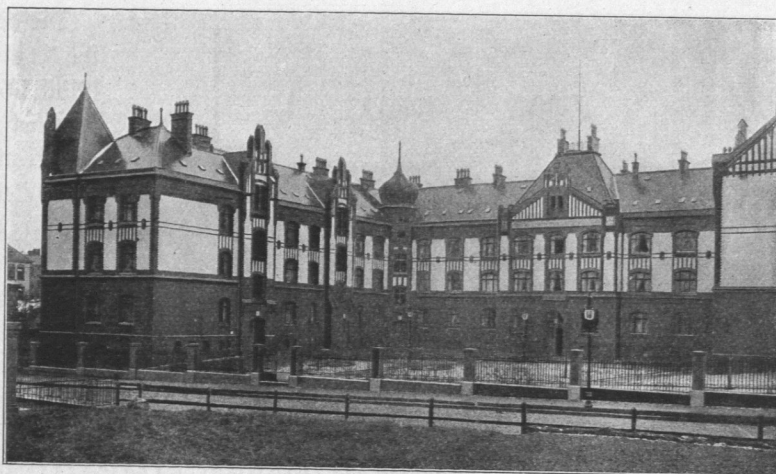
Abb. 563. Vom Kampe und van den Wouwer Gotteswohnungen, Ansicht.
