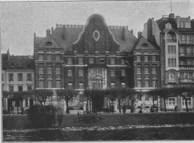
Abb. 559. August-Heerlein-Stift, Ansicht. Architekt Ernst P. Dorn.
